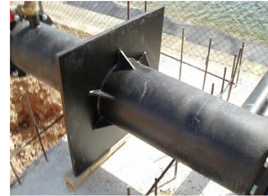
Detalle placa acartelada en pieza especial
