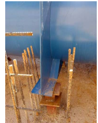
Detalle apoyo de la placa para montaje
